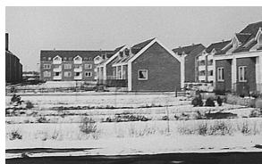
Vores blok i baggrunden fotograferet fra "Højvejen".
